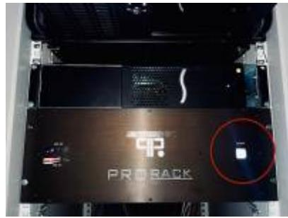
**4.** Netwerkkabel von „Studio Mitte“ auf „Level45“ umpatchen (an der Rückseite der Racks).
